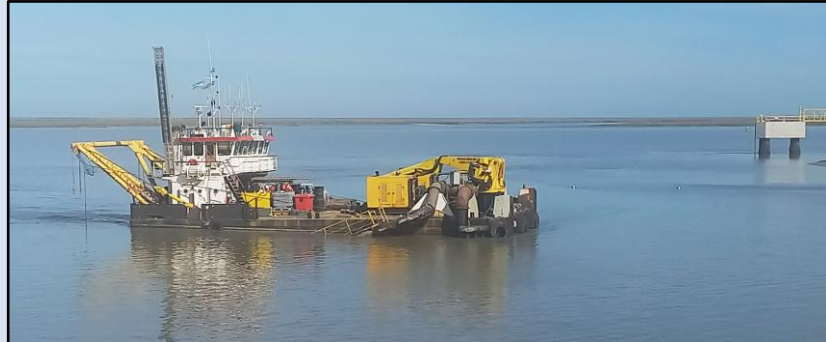
Draga DN28 en operación en Pto. De Ingeniero White
